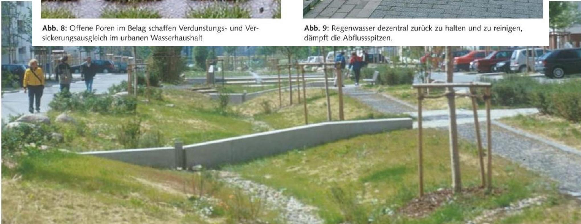
**Abb. 46:** Multifunktionale Gestaltung einer Allee mit Retentionskaskade
