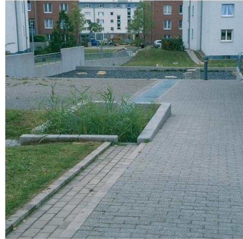
**Abb. 9:** Regenwasser dezentral zurück zu halten und zu reinigen, dämpft die Abflussspitzen.
